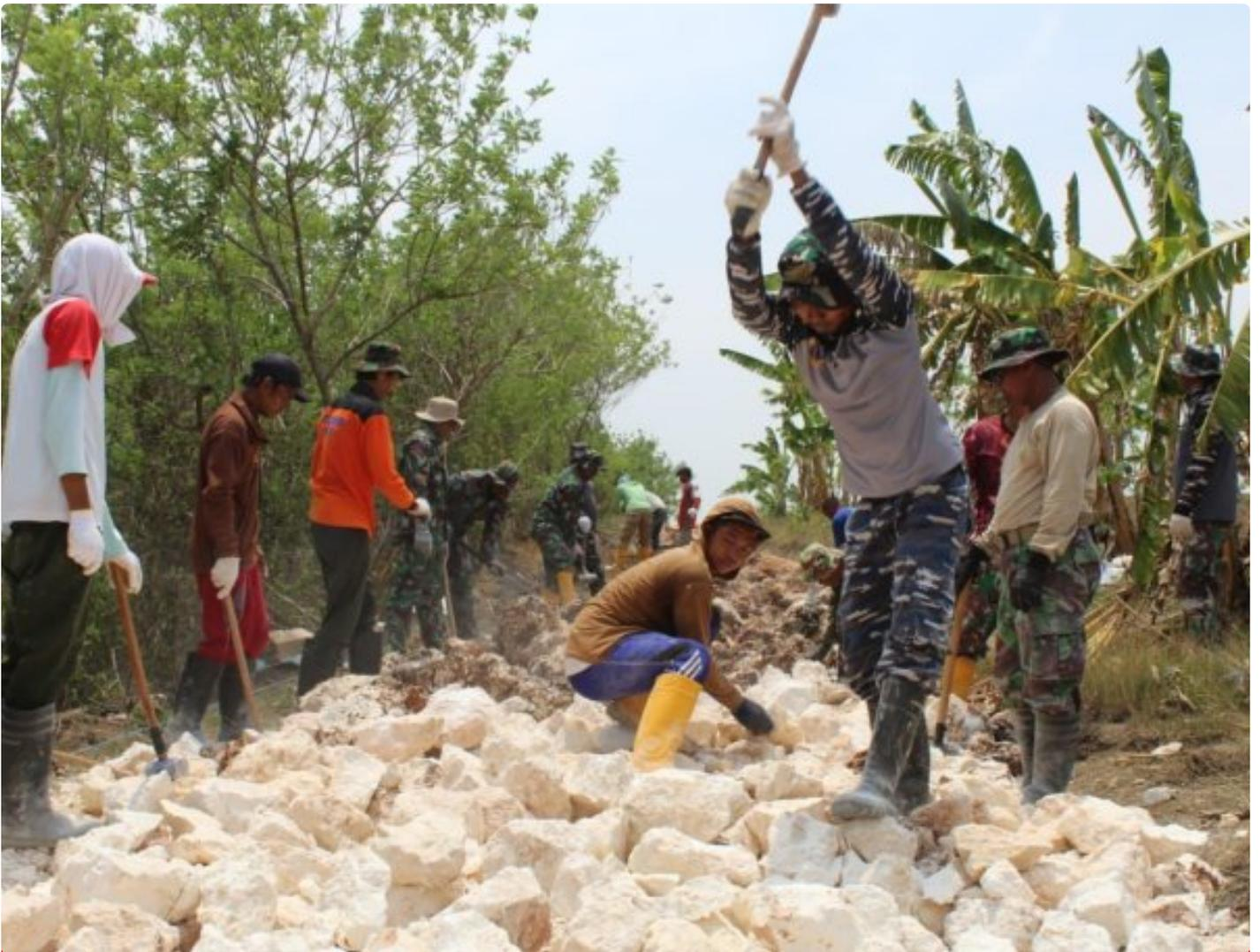
*Foto: Pembangunan jalan makadam sepanjang 1.700 Meter dengan lebar 3 Meter, yang menghubungkan Desa Sidomulyo ke jalan jalan utama Kecamatan Blora - Randublatung, Sabtu (19/10/2024).*
