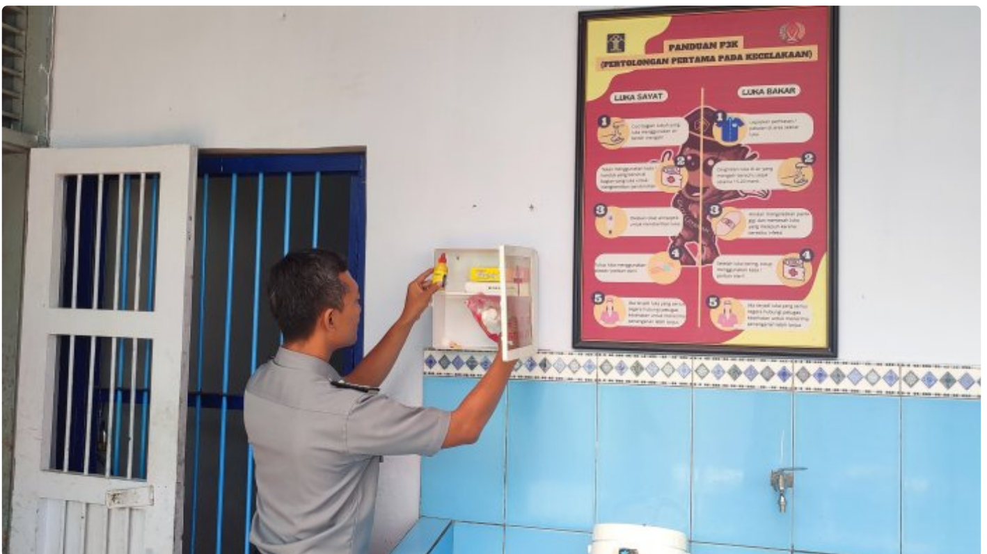
Tingkatkan Pelayanan Kesehatan, Rutan Blora Lakukan Kontrol Rutin Kotak P3K
